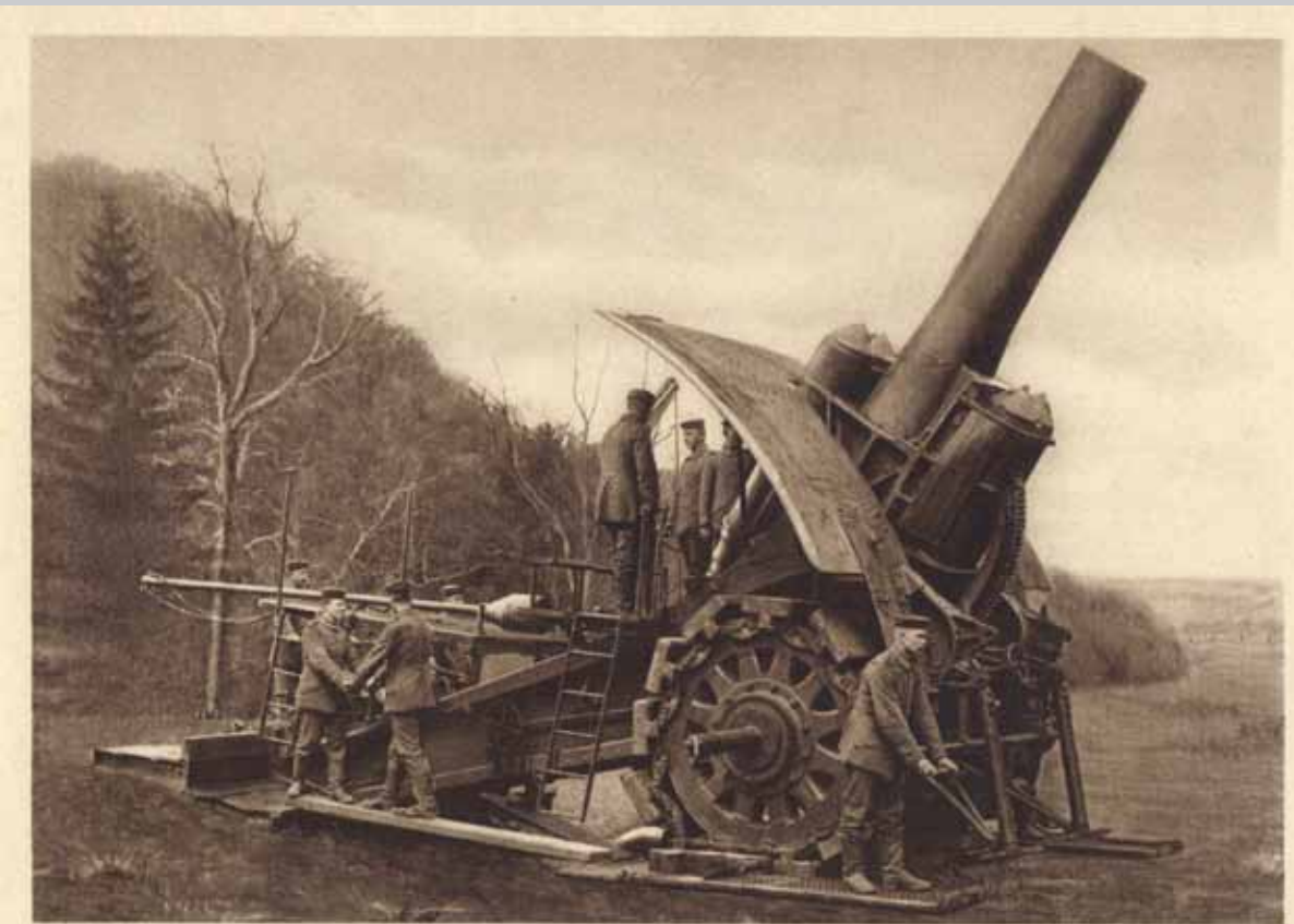
Ein 42 cm Mörser, dessen Verwendung bei Kriegsbeginn Aufsehen bei allen Mächten erregte. Das Gewicht eines Geschosses („balle Trete“) beträgt 900 kg, die Schußweite ca. 10 km. Der 42 cm Mörser entfaltete genügend als Primärartillerie der ersten Truppe durch das Versagen der Generallöhner, den eine unmittelbare Beschaffung des Nachschages unterlag war. Die Herbeileitung wollte ein Geschütz befehlen, das mit Sicherheit den Panzer- und Eisenbetonbauten der modernen Festungen gewachsen war.
